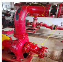
Modifications lignes d'admission/ Refoulement du nouveau groupe motopompe DCI.
