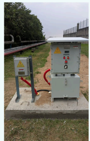
TRAVAUX DE PROTECTION CATHODIQUE
