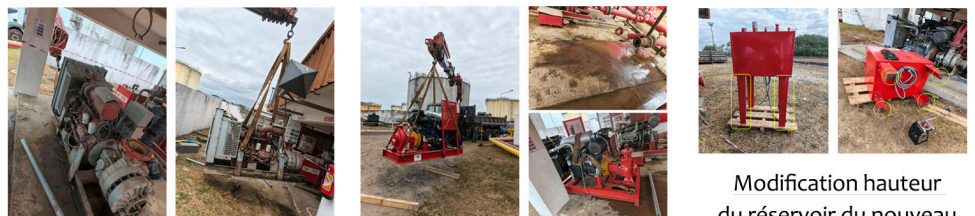
Dépose de l'ancien groupe motopompe DCI.
