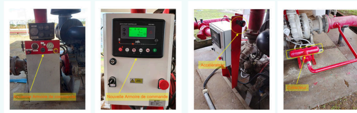
Collecteur, ancienne et nouvelle commandes groupe motopompe DCI.
