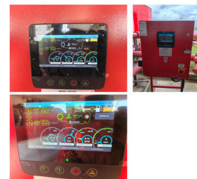
Pose, raccordement, mise sous tension, paramétrage et mise en service du nouveau groupe motopompe DCI.
