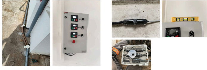
Armoire de commandes à distance des groupes motopompe DCI.
